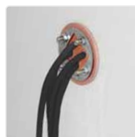
Percement pour passage de câbles PEXTBALI
