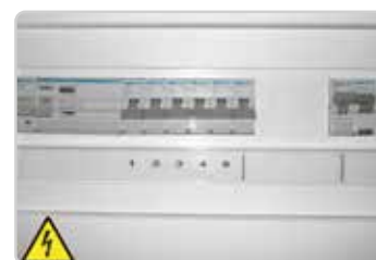
Intérieur du coffret électrique triphasé
