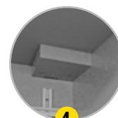
4 Orifices de ventilation avec thermofusible
