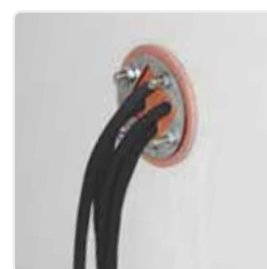
Percement pour passage de câbles PEXTBALI
