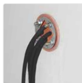
Percement pour passage de câbles PEXTBALI
