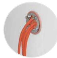
Percement pour passage de câbles PEXTBALI
